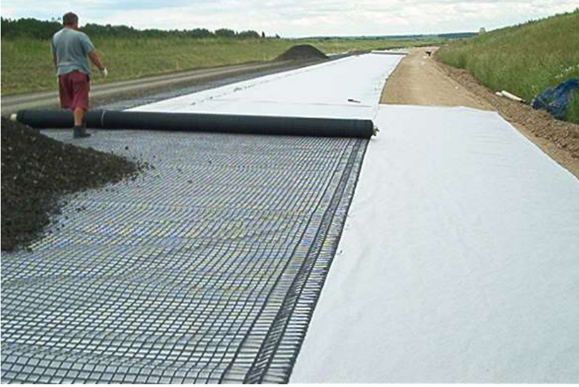
Şekil: Temel altında geogrid kullanılması (Kocaer 2011).
