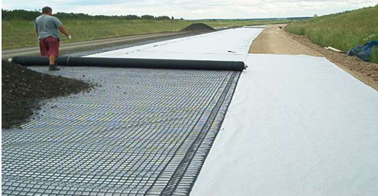
Şekil: Temel altında geogrid kullanılması (Kocaer 2011)
