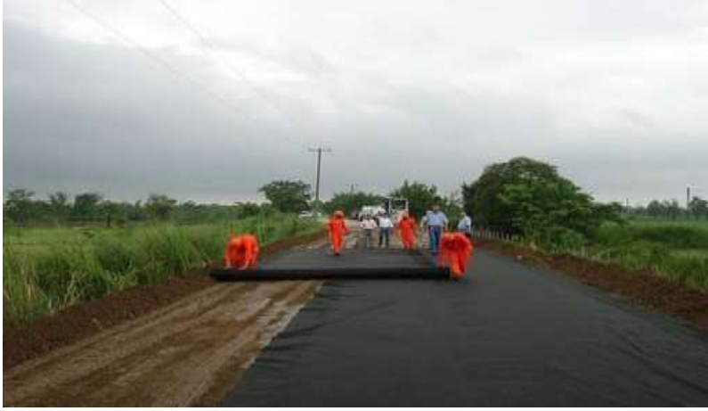
Sekil: Yol tabanına geotekstil serimi, Meksika (Url 1)
